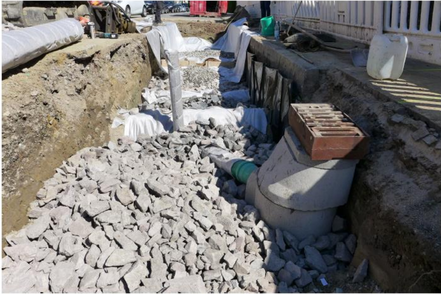
Praxisbeispiel: Bau eines Rigolenstrangs mit Verbindung der einzelnen Baumstandorte untereinander (hier: grundsanierte Straße in Essen). Das Regenwasser fließt hier durch das natürlich Längsgefälle der Straße durch alle Baumstandorte. Bauherrin: Stadt Essen Tiefbauamt und Grünflächenamt
