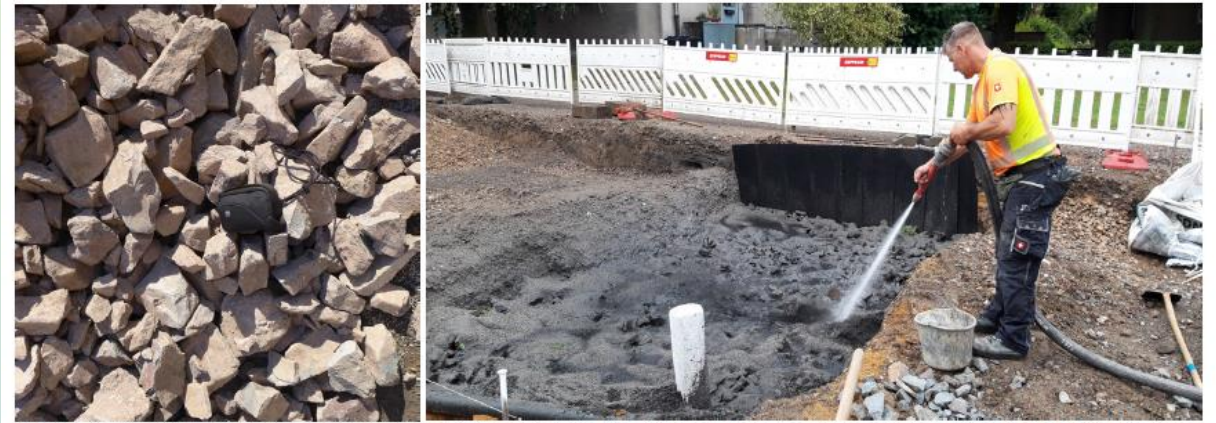
Praxisbeispiel: Grobschlag (bspw. Grauwacke 100/150mm) und nachfolgendes Einschlämmen von Feinsubstrat mit Mischung aus Sand und aufgeladener Pflanzenkohle (hier: Wasserstraße in Bochum-Ehrenfeld).
