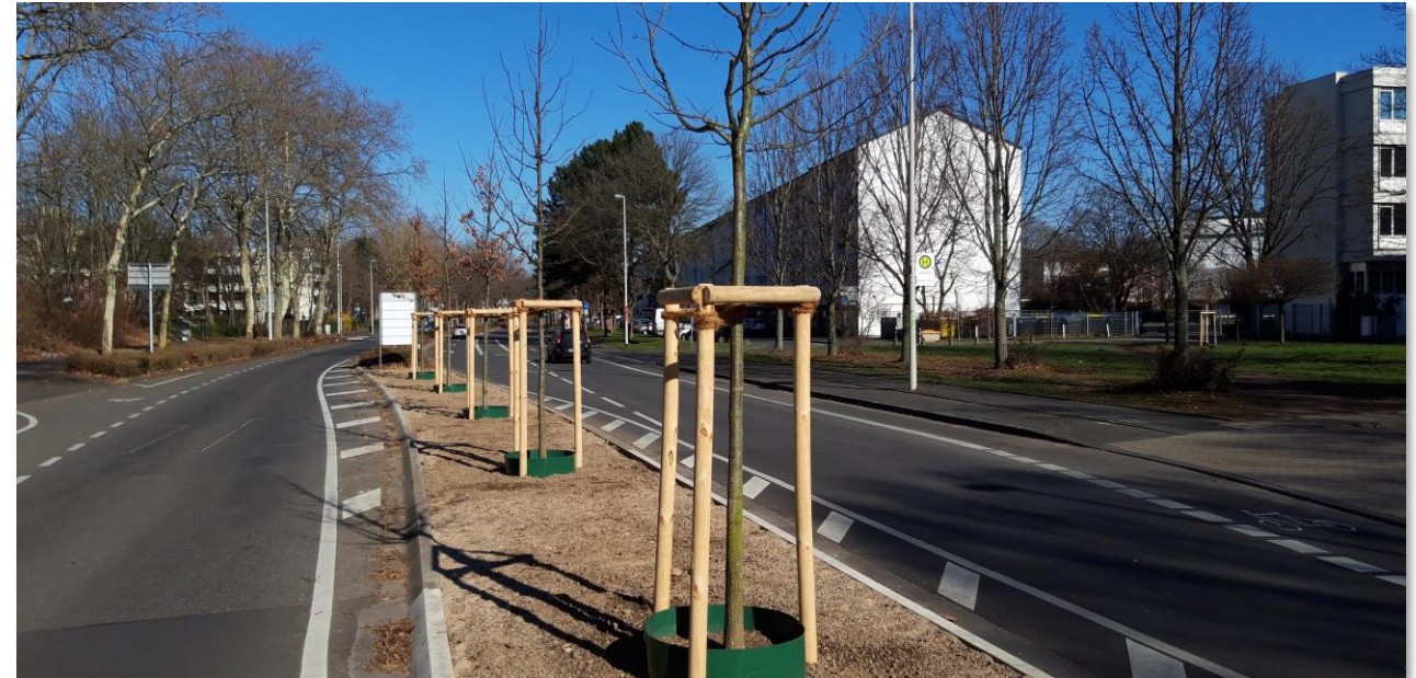
Herstellung von durchgehenden Wurzelgräben
